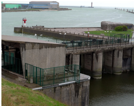
Exutoire des waterings, porte à la mer, ouvrage Tixier à Dunkerque ©Lilas59
